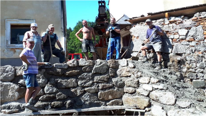
Neuerrichtung der alten Gartenmauer
