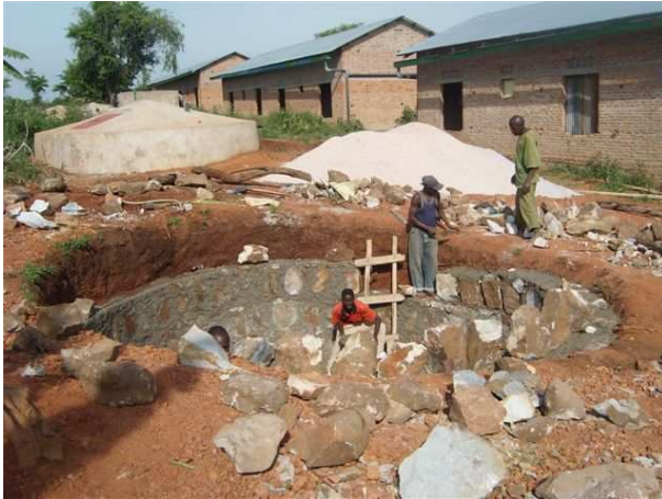
Schule im Rohbau und Wassertank
