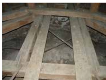
Zugstangen müssen in der Apsis eingesetzt werden
