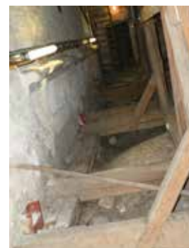
Neue Zugstangen über der Sakristei
