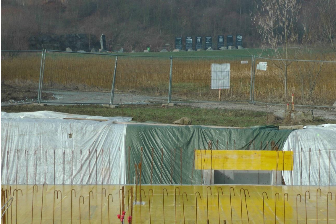
Abb. 8 Baustelle vor Stollenanlage (Quelle: Eigenes Foto, 2016)
