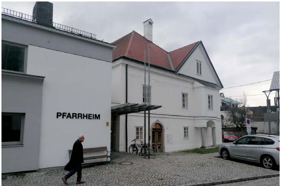
Der Pfarrhof und das Pfarrheim Ottensheim sollen künftig auch das neue Pfarrbüro für die gemeinsame Pfarre beherbergen. Fellingner
