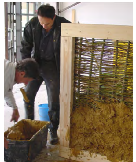
Probieren geht über studieren: Dazu wurde ein einzelnes Gefach als Muster angefertigt. Hier wird dieses mit Lehm verputzt.
