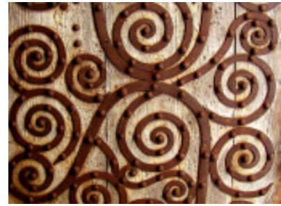
Pürgg: Westportal mit dem romanischen Türblatt, das zur Abwehr böser Geister Spiralen aus Schmiedeeisen trägt
