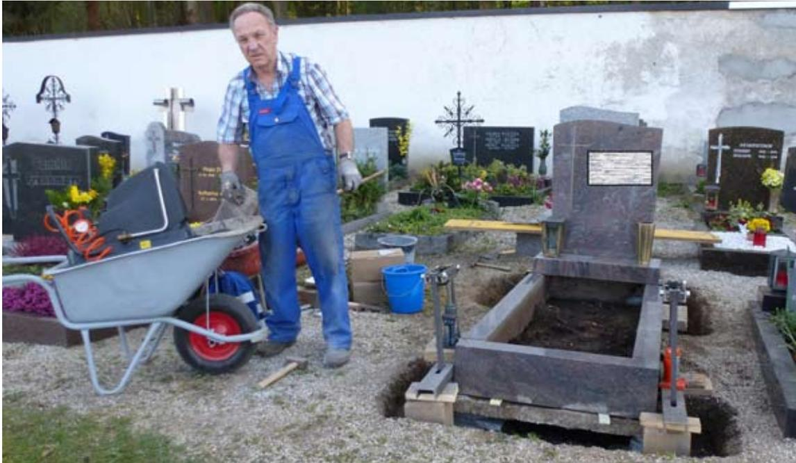
Die dazu zweckmäßigen Apparate hat er selbst erdacht und angefertigt. Unter vorhandene Fundamentplatten greifen je 2 Zugstangen, deren oberer Verbindungsbalken durch eine Presse mit Handantrieb gehoben wird. Die Presse stützt sich über den geschlitzten unteren Balken provisorisch auf das Erdreich.
