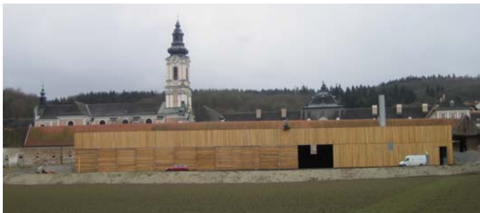
Das neue Biomasse - Heizwerk des Stiftes
