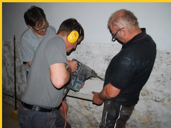
Stemmen für Elektroarbeiten
