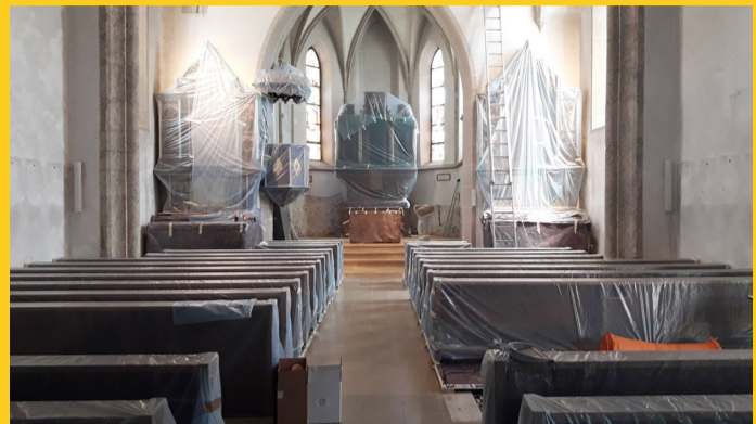
Vorbereitungsarbeiten: ausräumen, abdecken, einhüllen.
